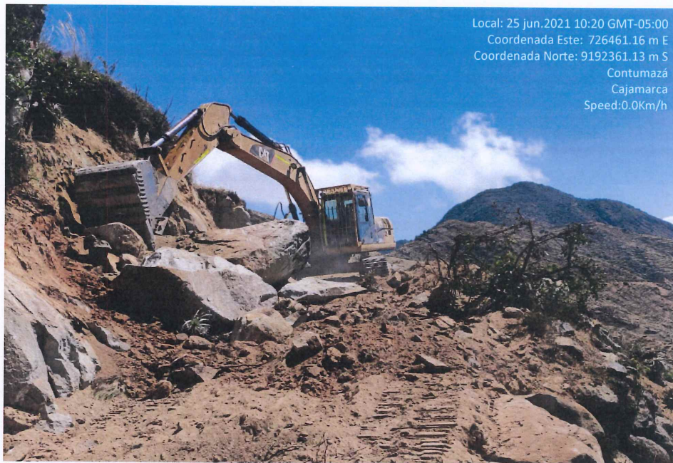
Fotografía 7. Ensanchamiento del camino vecinal con excavadora.
