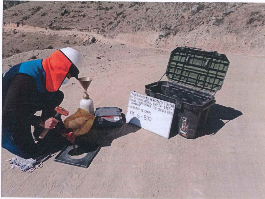
FIGURA N° 27. Ensayo de Densidad de Suelo en Campo. Progresiva 06 + 500 (Método del cono de arena).
