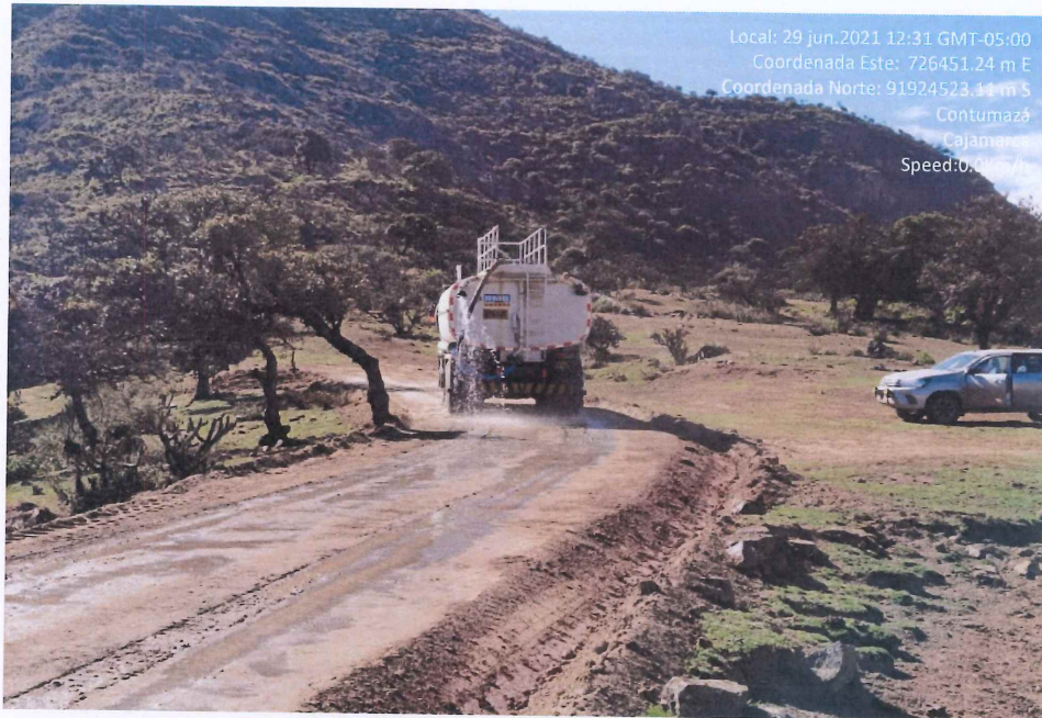
Fotografía 31. Riego de material de afirmado.
