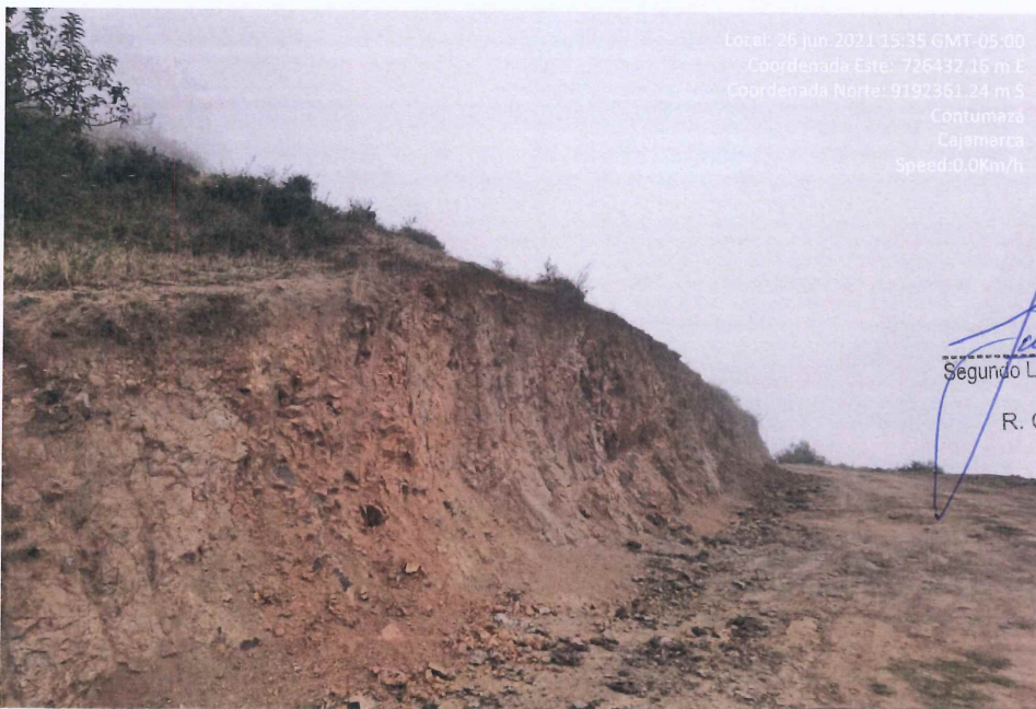
Fotografía 12. Resultado del ensanchamiento del camino vecinal con excavadora.
