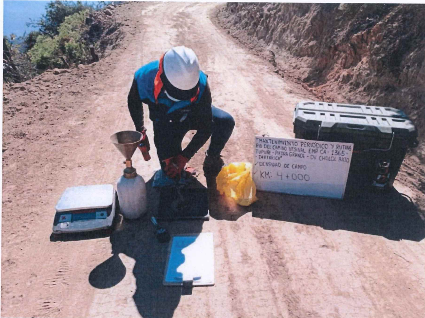
FIGURA N° 17. Ensayo de Densidad de Suelo en Campo. Progresiva 04 + 000 (Método del cono de arena).
