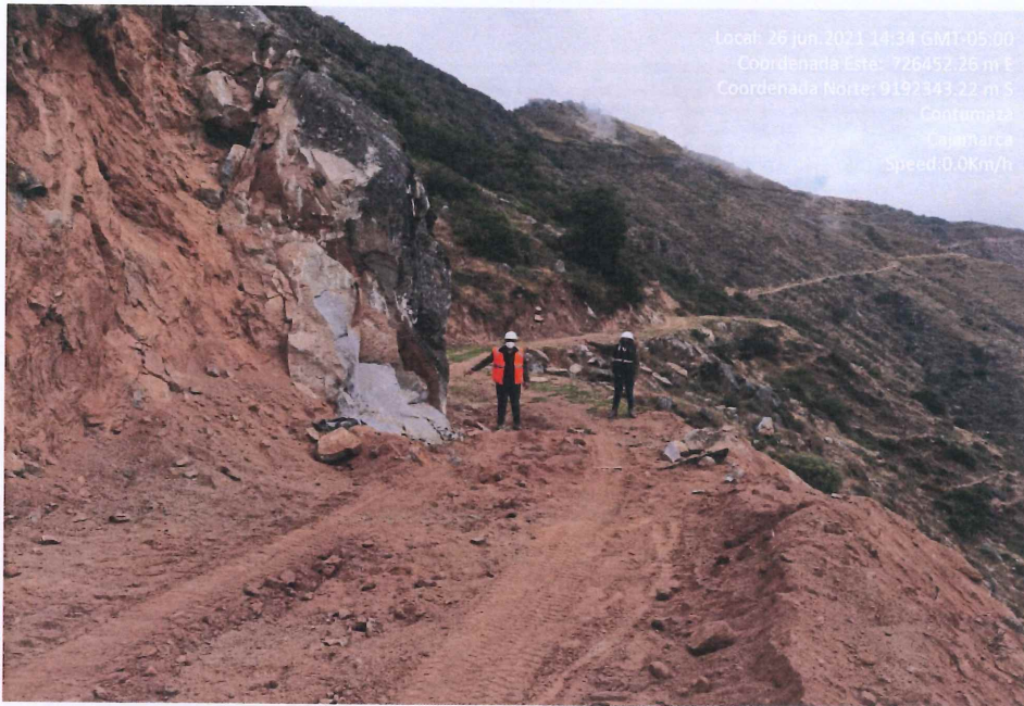
Fotografía 11. Resultado del ensanchamiento del camino vecinal con excavadora.
