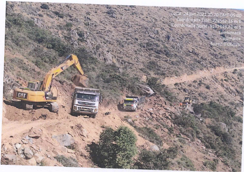
Fotografía 17. Carguío del material de cantera para el afirmado.
