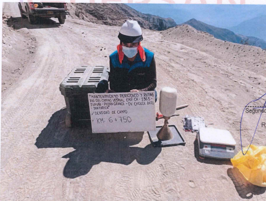
FIGURA N° 28. Ensayo de Densidad de Suelo en Campo. Progresiva 06 + 750 (Método del cono de arena).
