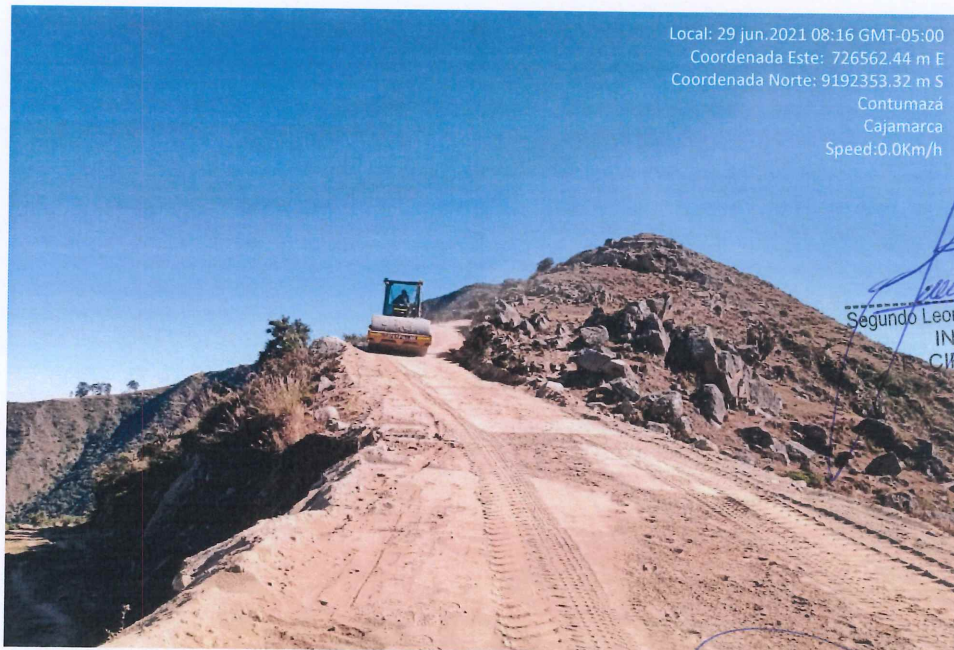
Fotografía 26. Compactación de material granular bajo afirmado e=0.15m
