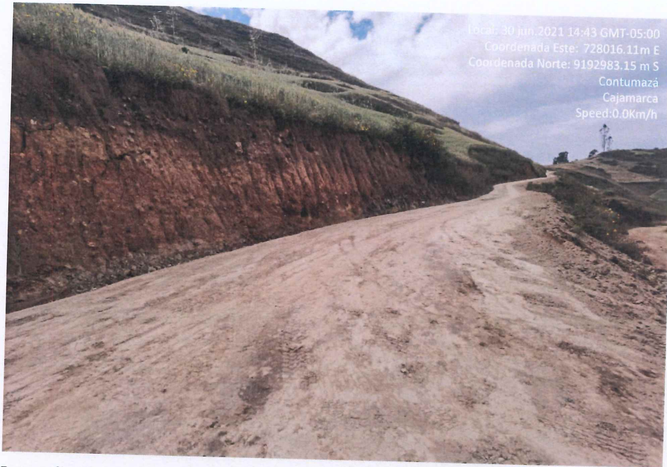
Fotografía 41. Resultado del refine y compactación del material granular para afirmado e=0.15m
