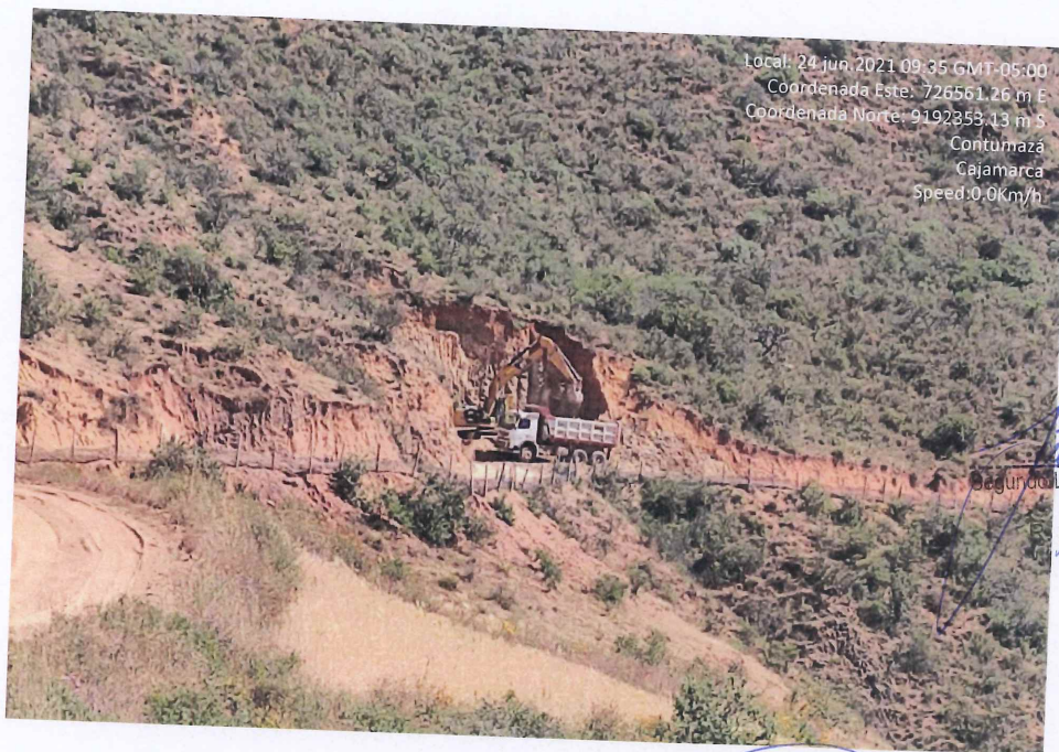
Fotografía 16. Carguío del material de cantera para el afirmado.
