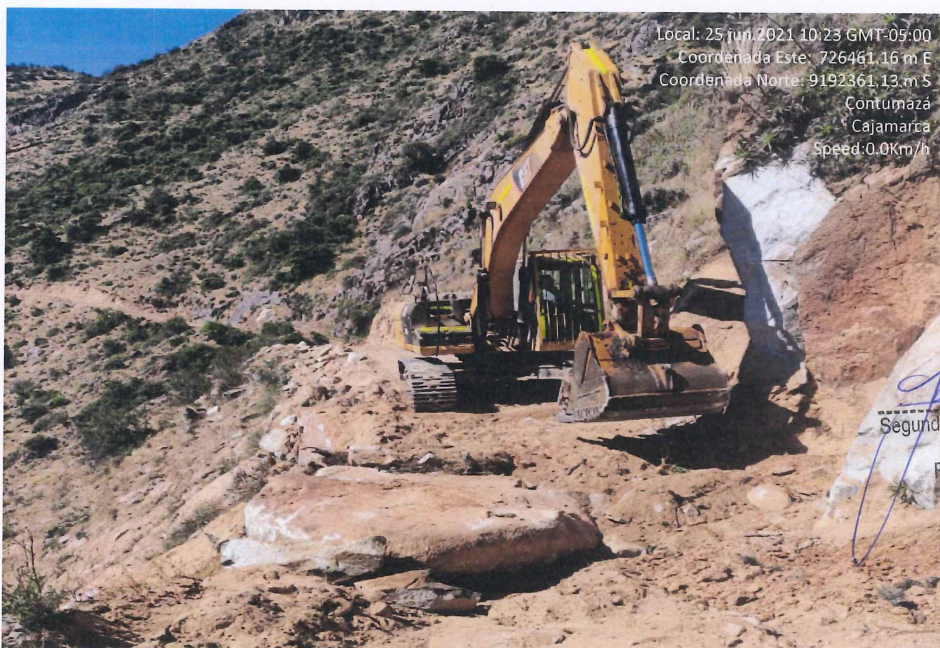
Fotografía 8. Ensanchamiento del camino vecinal con excavadora.
