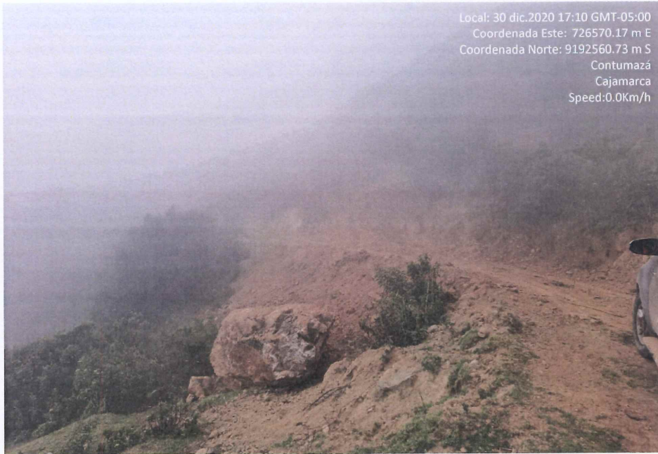
Fotografía 1. Estado del tramo antes de la suspensión de la Fase II.
