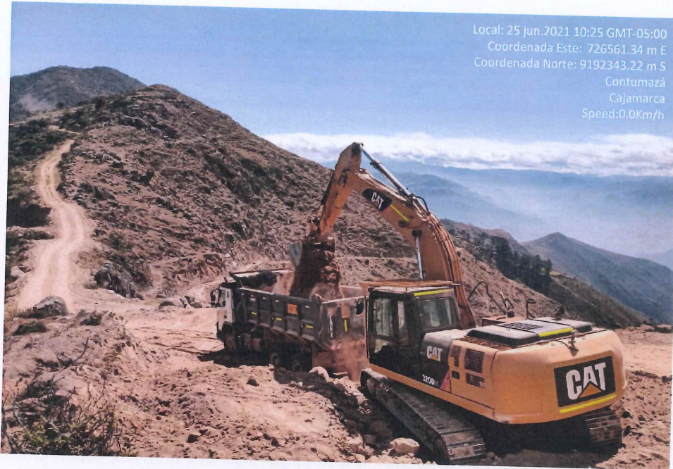
Fotografía 19. Carguío del material de cantera para el afirmado.
