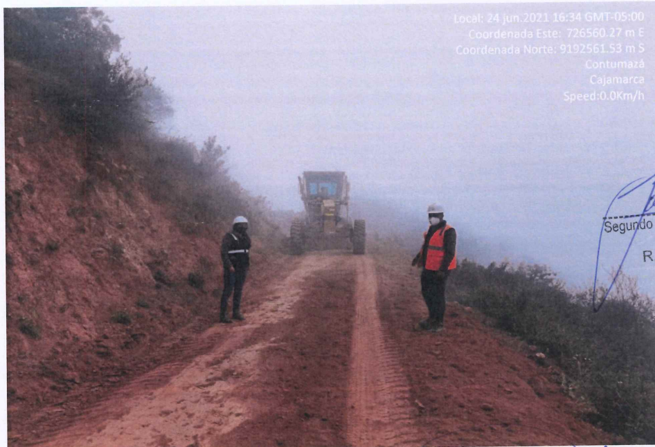
Fotografía 4. Trabajos de mejoramiento de la subrasante.
