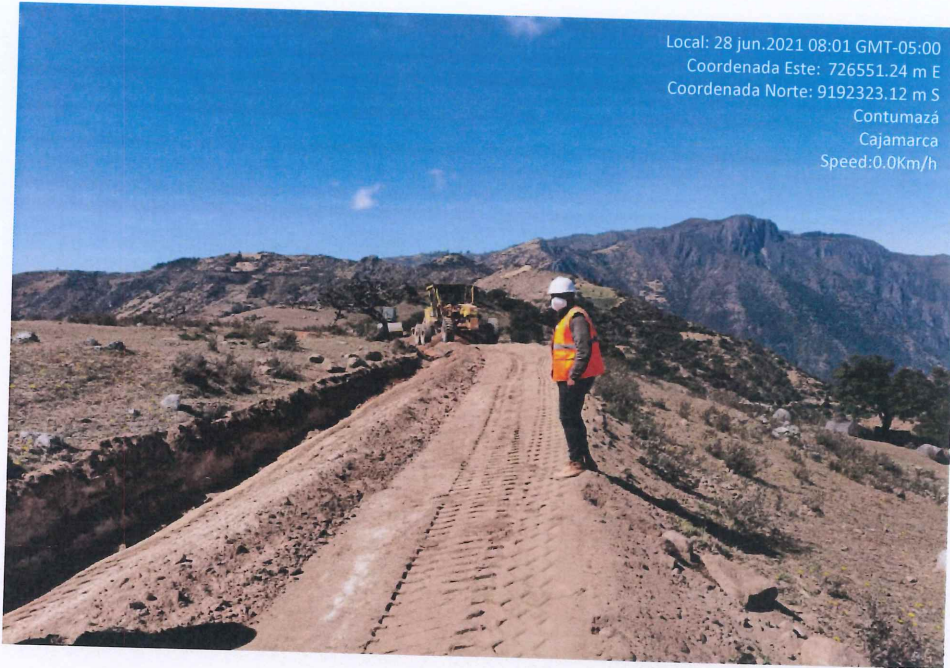
Fotografía 23. Conformación de la carpeta del afirmado y reconformación de cunetas.
