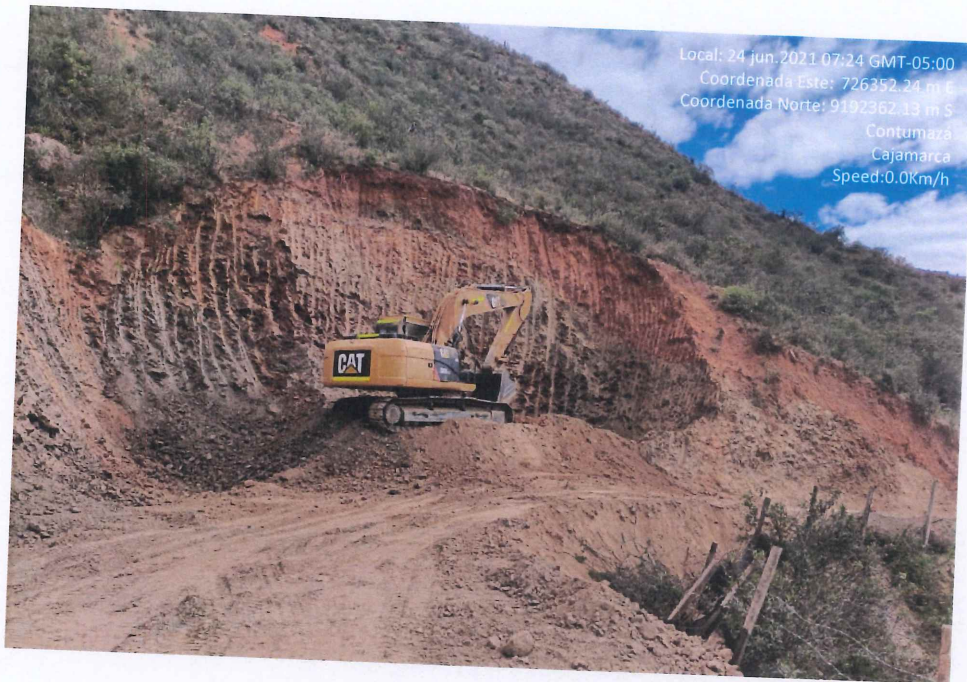
Fotografía 15. Extracción y preparación de material de cantera para el afirmado.
