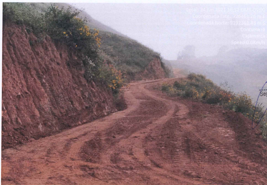
Fotografía 6. Resultado de los trabajos del mejoramiento de la subrasante.
