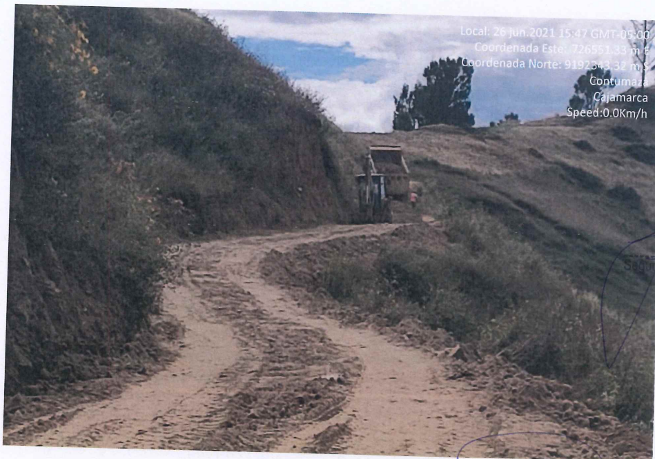
Fotografía 22. Descarga y extendido del material para el afirmado.
