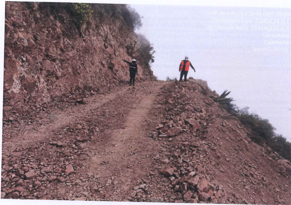
Fotografía 13. Resultado del ensanchamiento del camino vecinal con excavadora.
