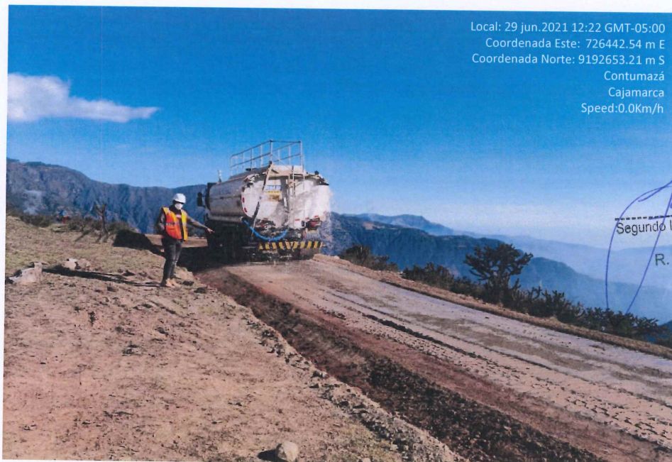
Fotografía 32. Riego de material de afirmado.
